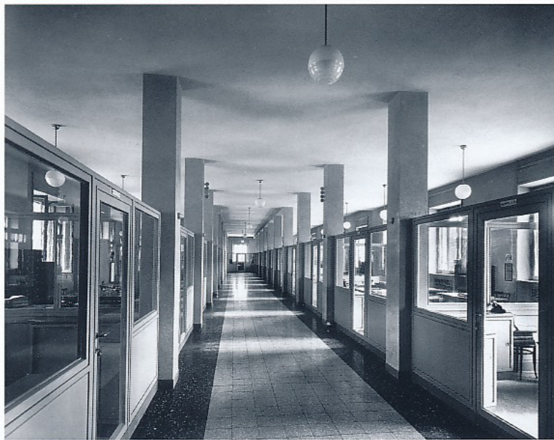
Comando Aeronautico Militare, Milano. Interni: si notino le pareti mobili tra gli uffici e il corridoio, 1942.
