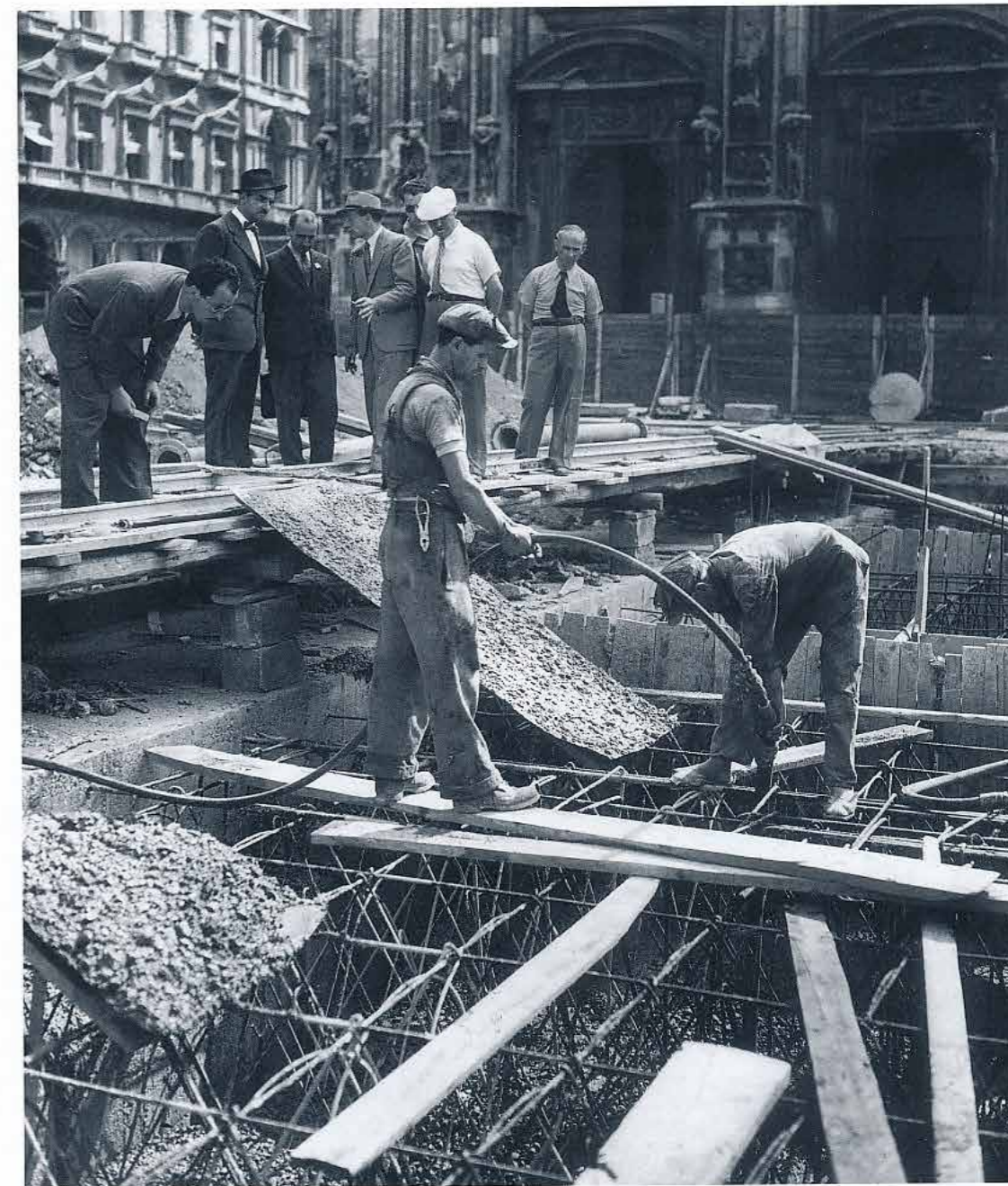
Rifugio antiaereo, piazza del Duomo, Milano. Visita di Secchi al cantiere (archivio Impresa A. Morganti).
