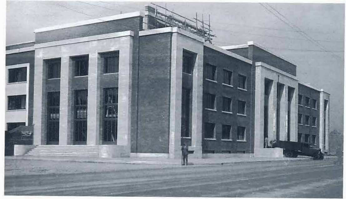
Piscina coperta Roberto Cozzi, Milano. La facciata su viale Tunisia e il salone delle vasche, 1934.
